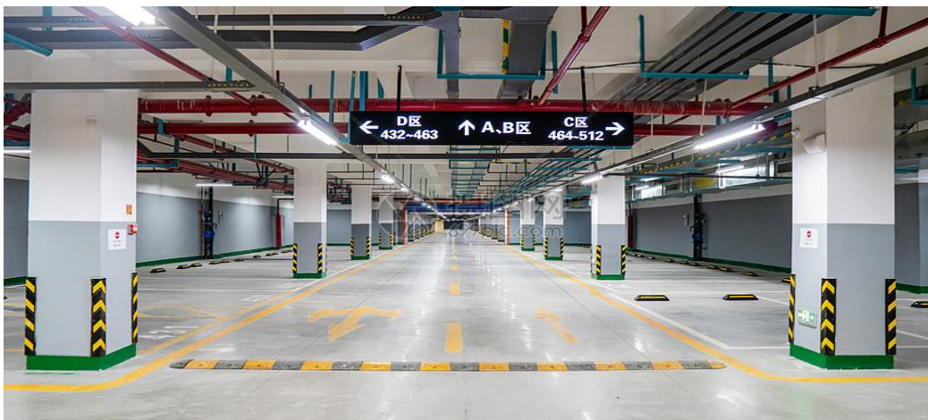
图 3-1-1 该小区地下停车库现场实拍
