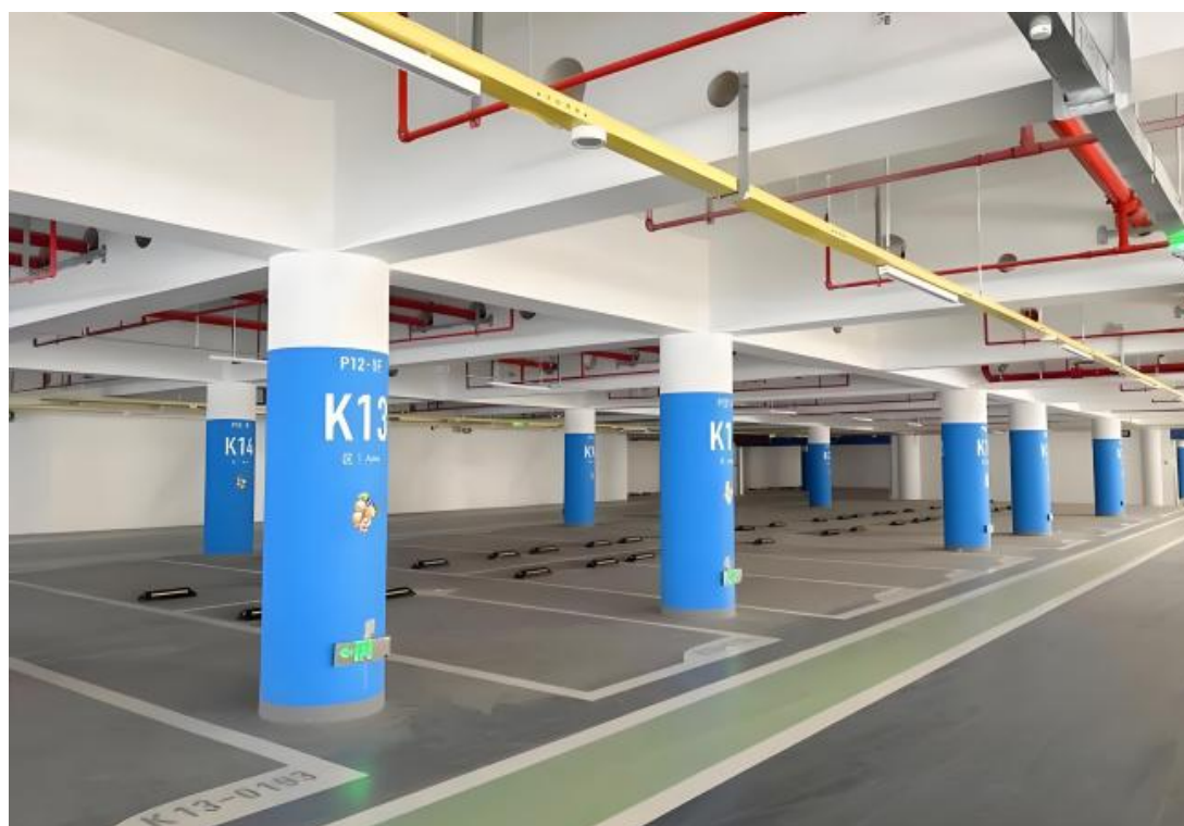
图 3-2-1 项目现场情况
