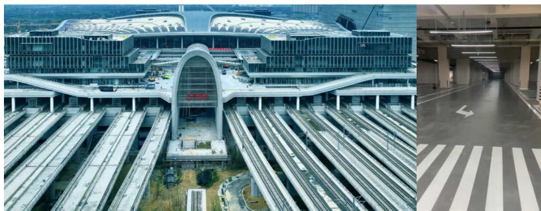
图 3-2-2 项目现场情况
