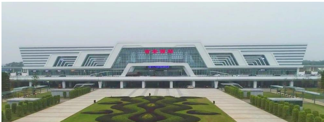
图 3-2-4 项目现场情况
